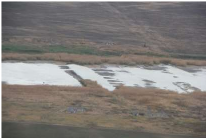
Рисунок 5.6 – Участок степной реки после прокладки трубопровода
